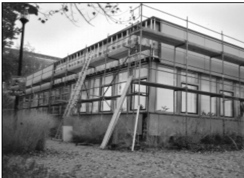
Letzte Arbeiten an der Außenhülle des Rechenzentrums - inzwischen sind die Arbeiten abgeschlossen. Foto: Olaf Riedel
